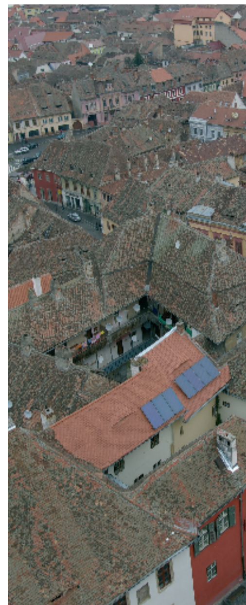
Ein Lichtblick: Solarzellen auf dem Dach des Gästehauses der Hermannstädter Kirchengemeinde. Fotos: Johannes Ernst
