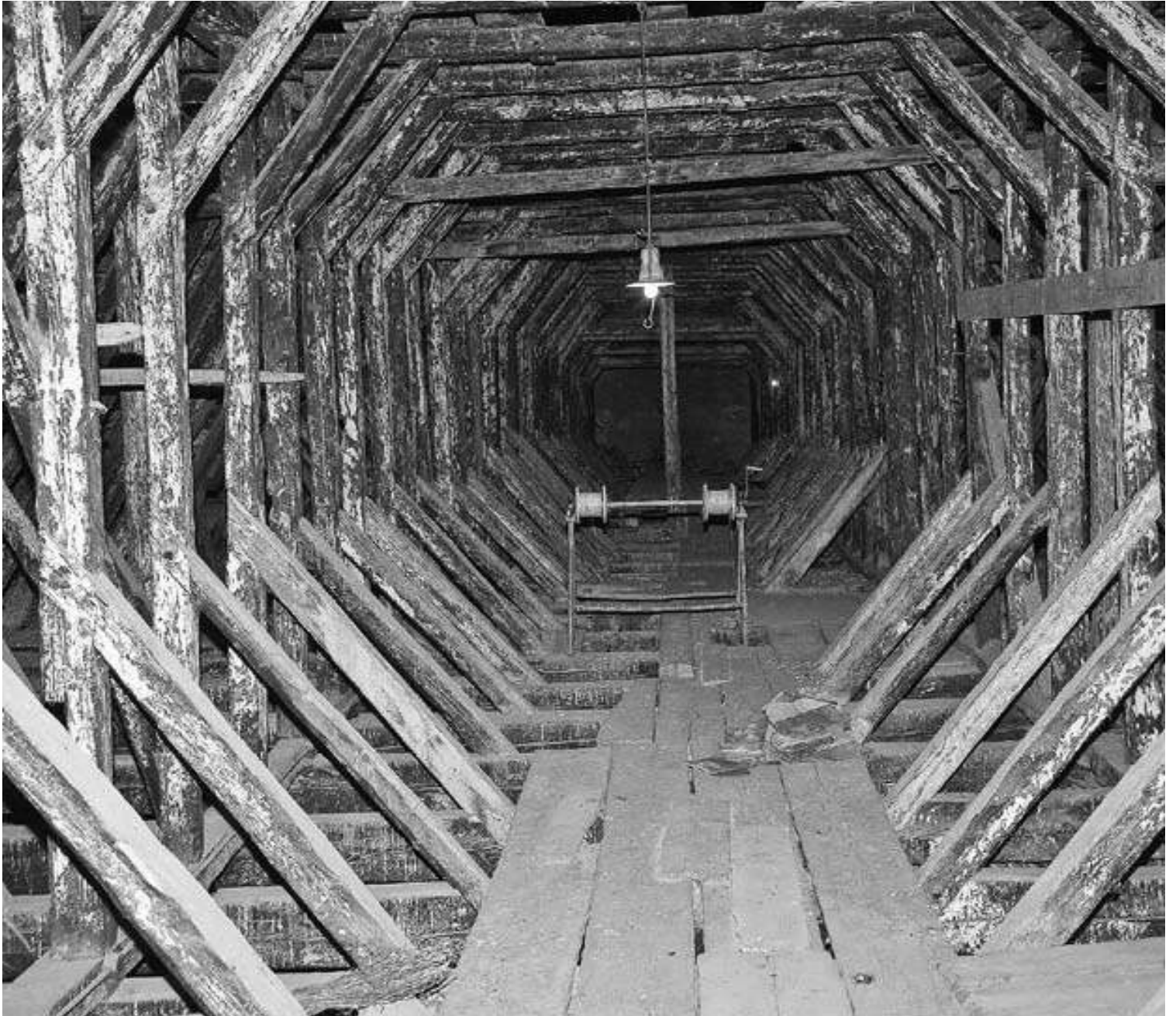
Blick in den historisch wertvollen Dachstuhl des Mittelschiffs der Stadtpfarrkirche
