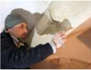
Verfugen der Gewölberippen
