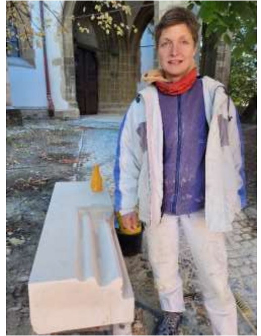
Stein-restauratorin Pia Prade aus Hammersdorf erneuert einen Stein der Laibung des Sakristei-Eingangs. Sie ist inzwischen für Arbeiten an Baudenkmalern akkreditiert.
