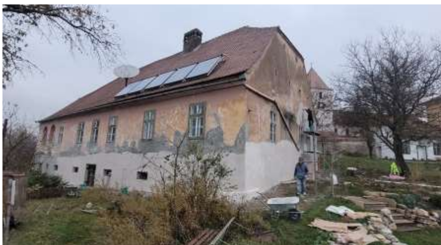
Das Hammersdorfer Pfarrhaus während der Renovierungsarbeiten im Spätherbst
